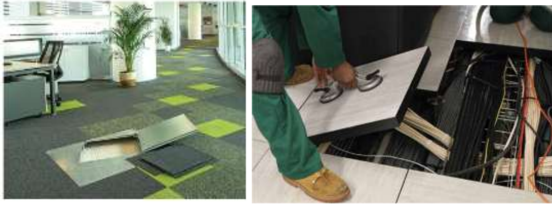
Şekil 2. Yükseltmiş döşeme sistemi
